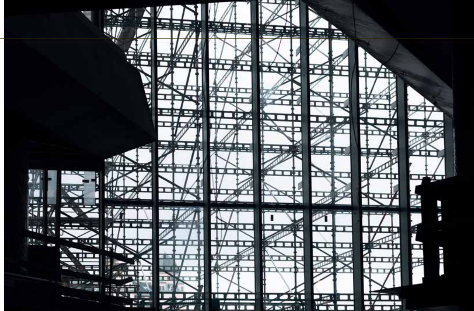
Det nya biblioteket byggs av Oslo kommun. Det ska stå klart i år och öppna för allmänheten 2020.
